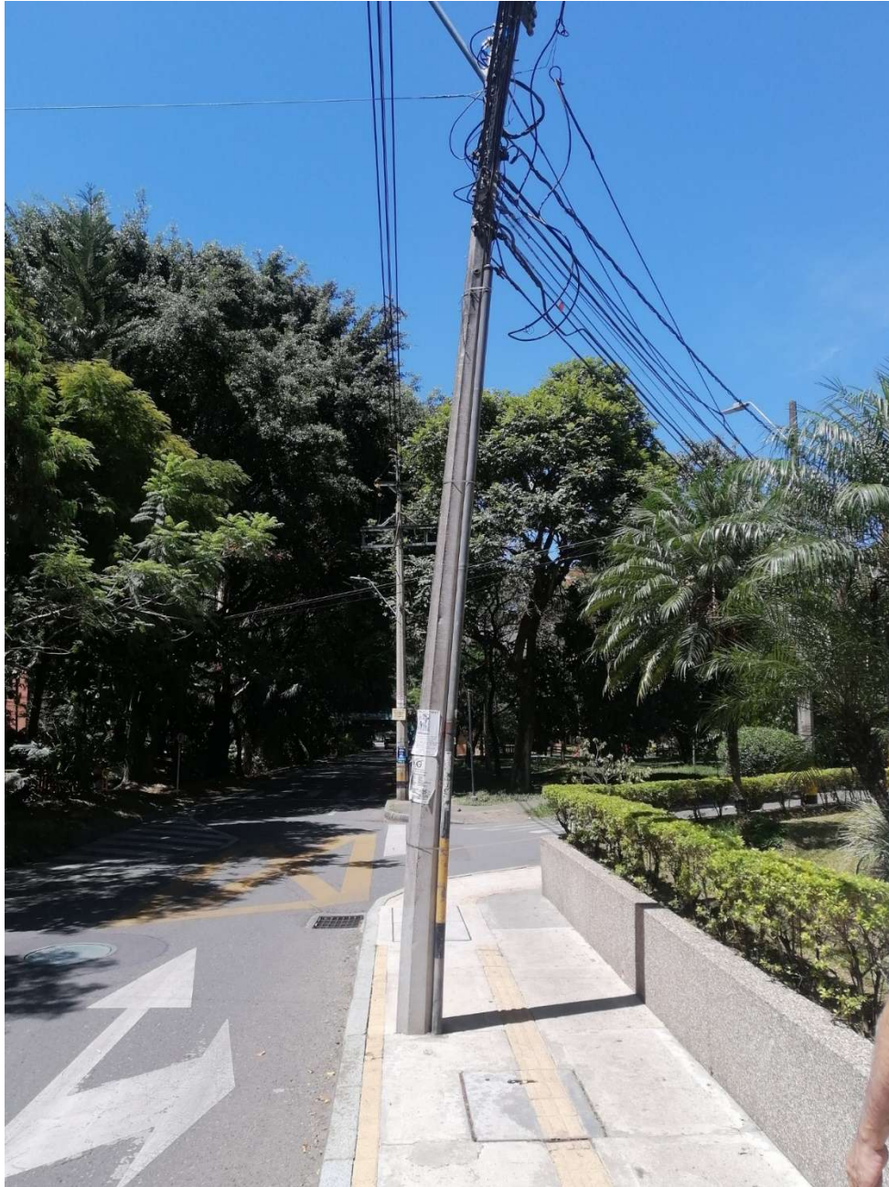
Imagen 2. Poste de alumbrado público destinado principalmente al tendido de redes de telecomunicaciones (fotografía sentido occidente - oriente)
